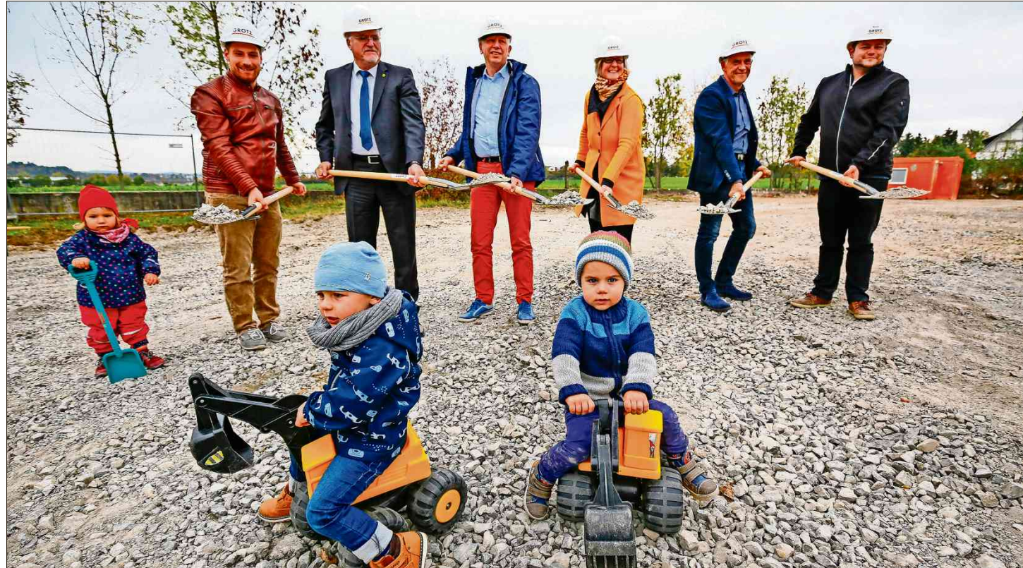
Daniel Dreßen, Wolfgang Faißt, Dietmar Grund, Architektin Silke Waldmann-Eboni (hinten, von links) beim Spatenstich. Foto: fact./Granville
